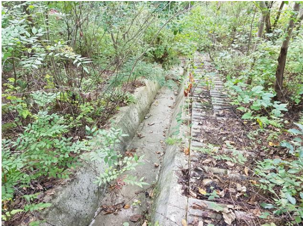
산마루측구, 점검계단 전경
