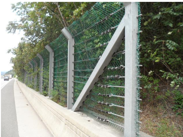
도로, 낙석방지울타리 전경
