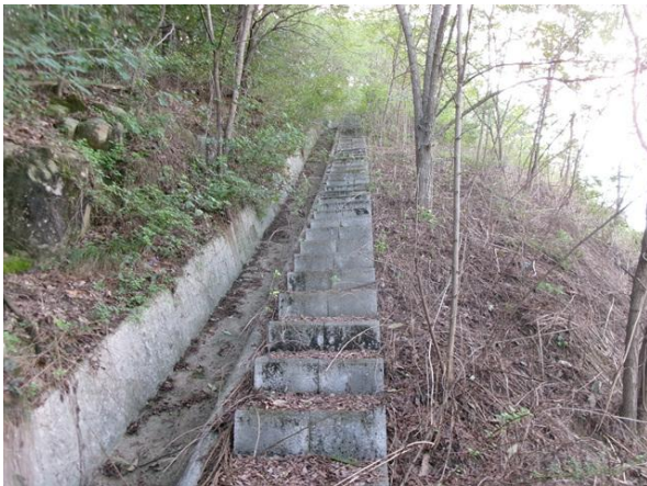
산마루측구, 점검계단 전경
