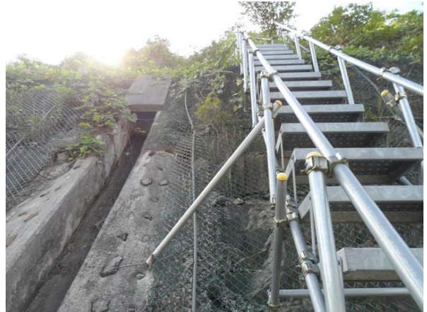
수직도수로, 점검계단 전경
