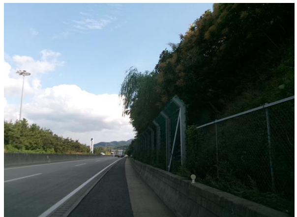
도로, 낙석방지울타리 전경
