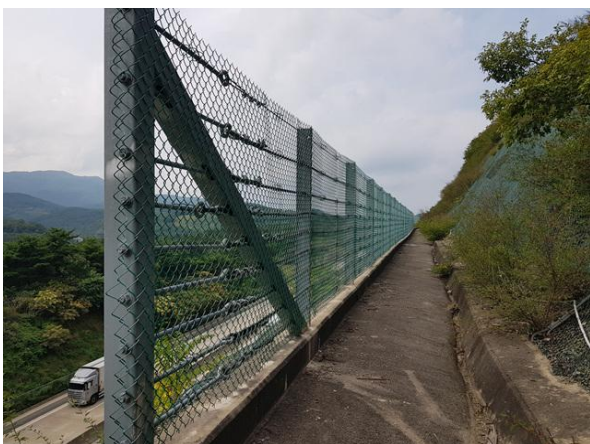
소단배수로 낙석방지울타리 전경
