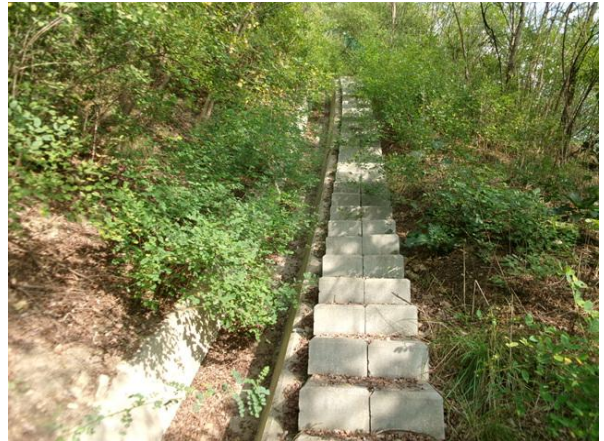
산마루측구, 점검계단 전경
