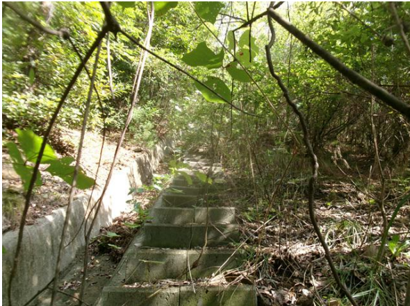
산마루측구, 점검계단 전경
