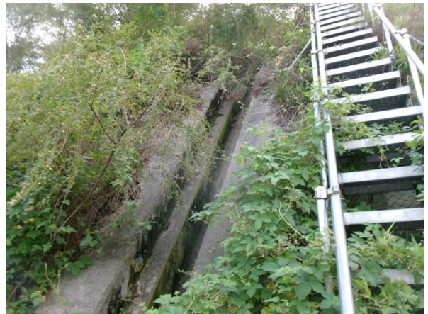
수직도수로, 점검사다리 전경
