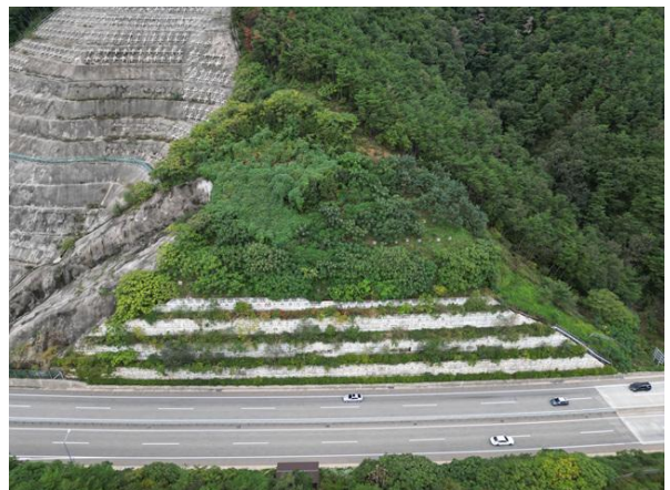
사면내 옹벽(패널식옹벽05) 전경
