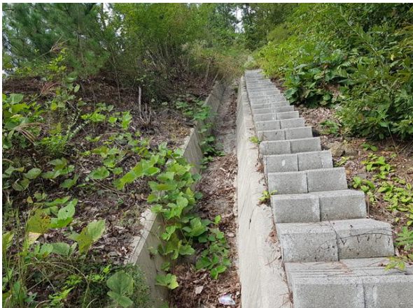
점검계단, 산마루측구 전경
