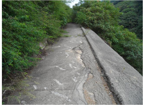
1소단 배수로 전경
