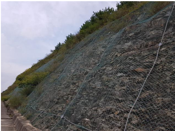
3단 풍화구간, 낙석방지망 전경
