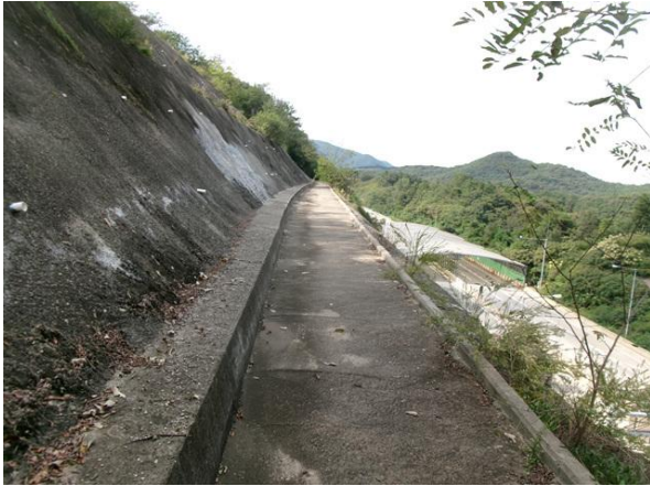
1소단 배수로 전경
