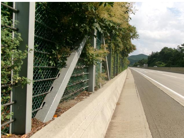
도로, 낙석방지울타리 전경
