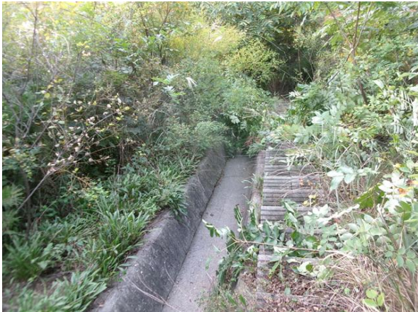
산마루측구, 점검계단 전경
