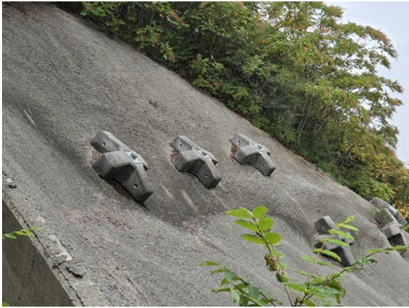
슛크리트, 격자블럭 전경
