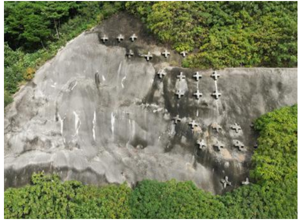
슛크리트, 격자블럭 전경
