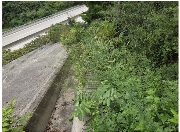
점검계단, 산마루측구 전경
