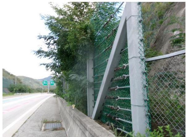
도로, 낙석방지울타리 전경
