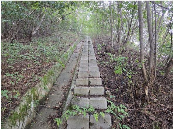
산마루측구, 점검계단 전경
