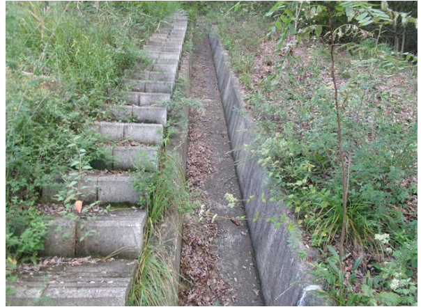
점검계단, 산마루측구 전경
