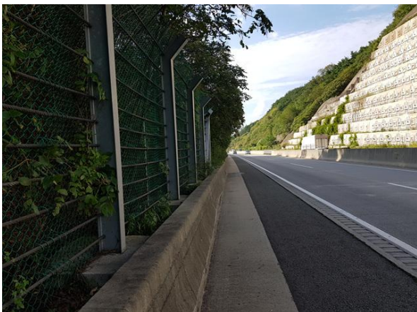
도로, 낙석방지울타리 전경
