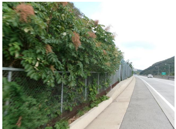
낙석방지울타리, 야생동물유도울타리 전경
