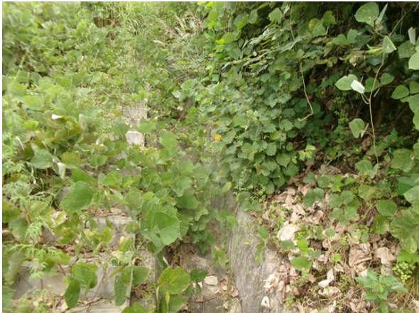
산마루측구, 점검계단 전경
