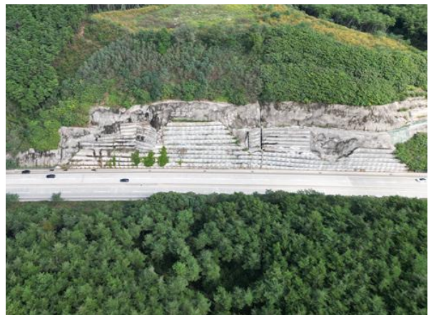
사면내 옹벽 전경
